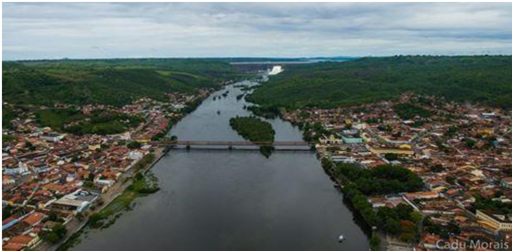
Imagem 3 - Cachoeira e São Félix ligadas pelo Rio Paraguaçu com vista para a Barragem e Lago de Pedra do Cavalo, com todas as comportas abertas.
