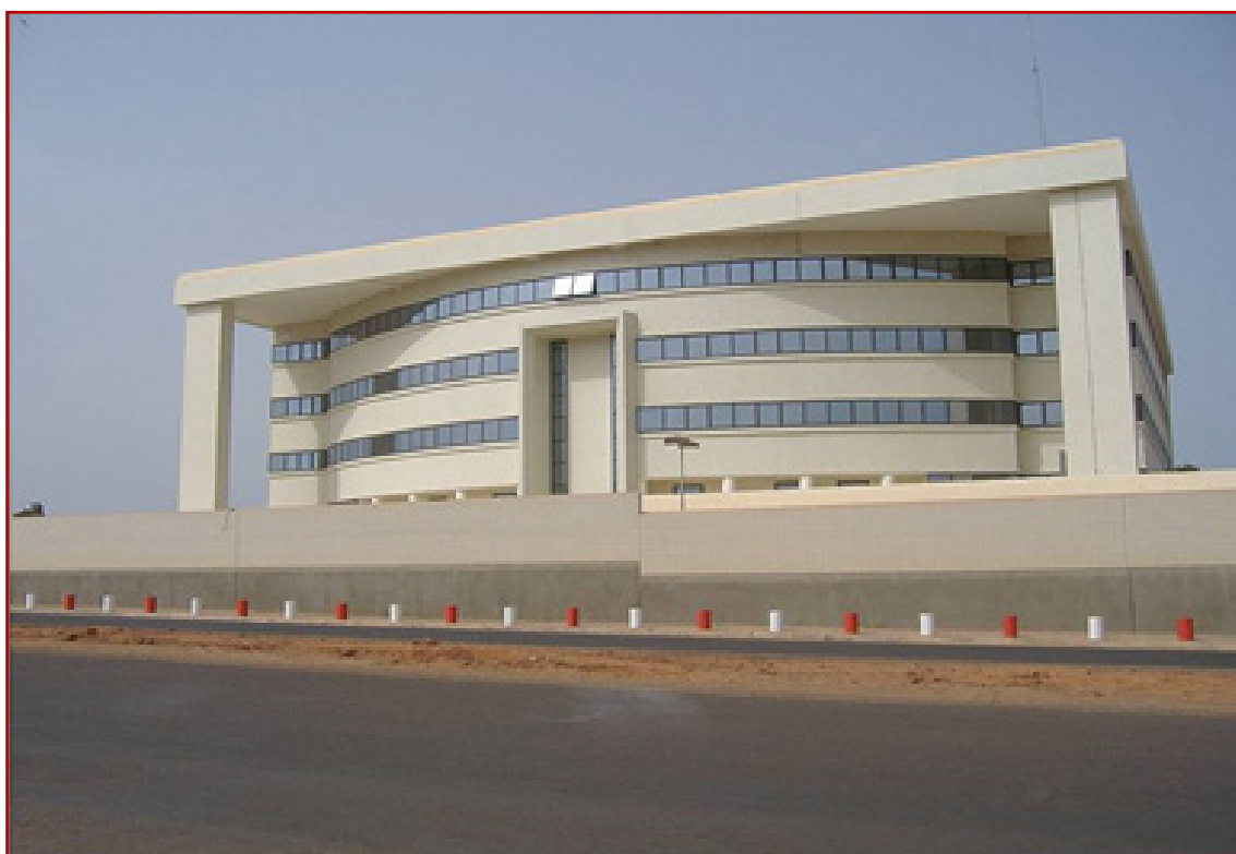
Figura 9: Edifício do Banco Nacional da Guine Bissau. Todo climatizado e com fortes problemas de temperatura ambiente devido a escassez de energia
