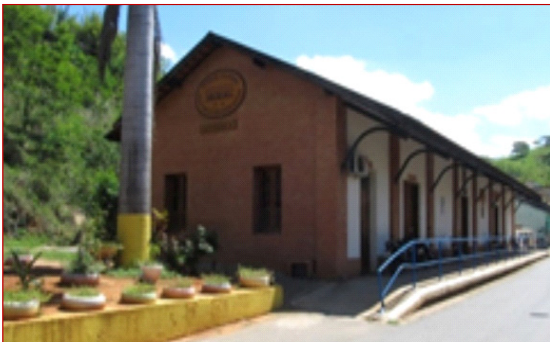
Figura 10: Estação Ferroviária de Natividade 2018 Fonte: http://www.estacoesferroviarias.com.br
