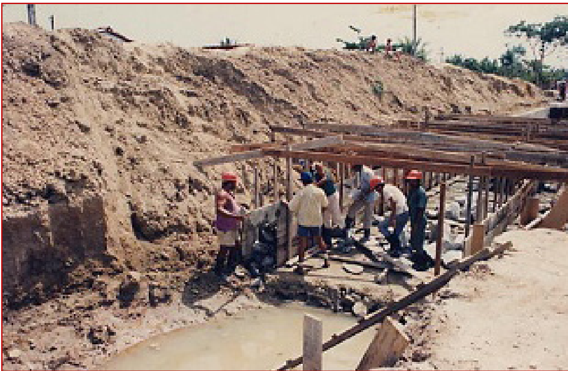
Figura 6 Foto da construção do Canal de Drenagem na década de 1990.
