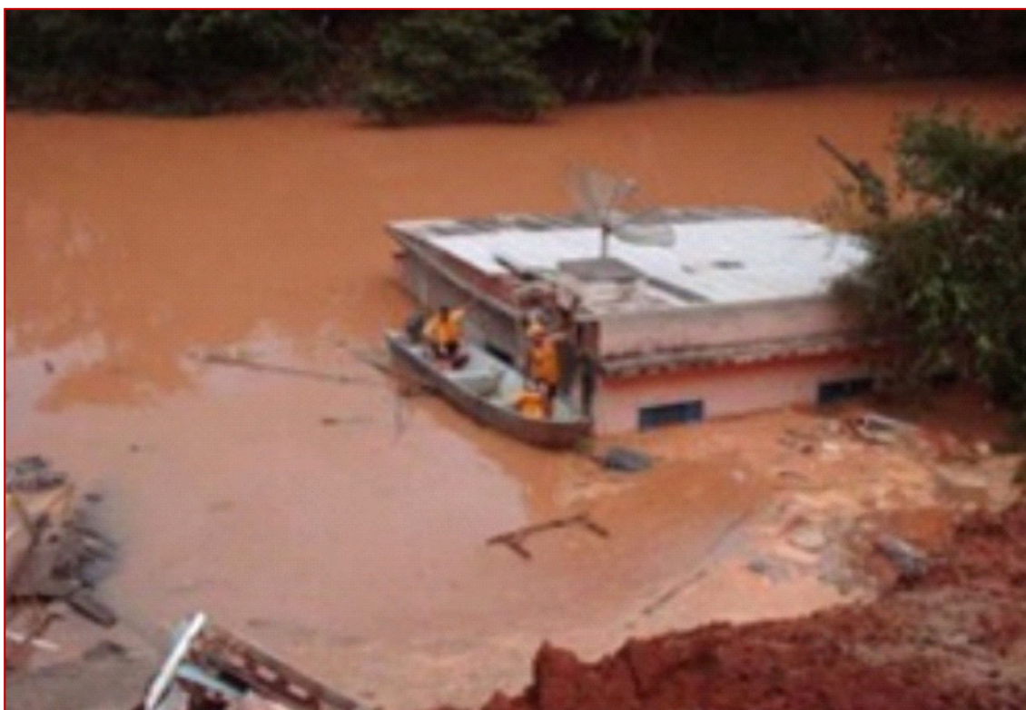
Figura 18: Casa que deslizou para dentro do Rio Carangola Fonte: https://informenatividade.wordpress.com/2012/02/24/deslizamento-de-terra-destroi-duas-casas-em-natividade/
